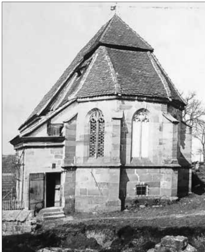
Die baufällige Altensteiner Kirche aus dem Jahr 1561 musste einem Neubau (1910) weichen.
