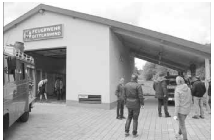
Zufrieden zeigte sich der Bauausschuss mit dem Baufortschritt des Feuerwehrhauses in Ditterswind, wo derzeit Gerald Hellmuth (links neben dem Feuerwehrauto) noch mit Ausbaurbeiten beschäftigt ist.
