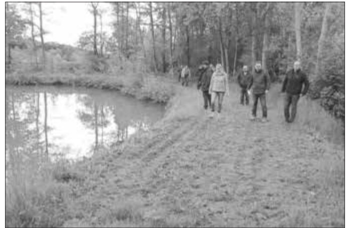
Bürgermeister Wolfram Thein (vorne Mitte), 2. Bürgermeisterin Heidi Müller-Gärtner (vorne links) und Gemeinderat Dieter Hepp (rechts) stehen mit dem Bauausschussmitgliedern an der Stelle, wo der Biber den Damm zwischen See und dem „Dippacher Grundgraben“ unterhöhlt hatte.
